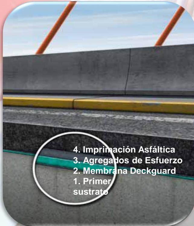
El sistema completo se compone y se instala de la siguiente forma:
