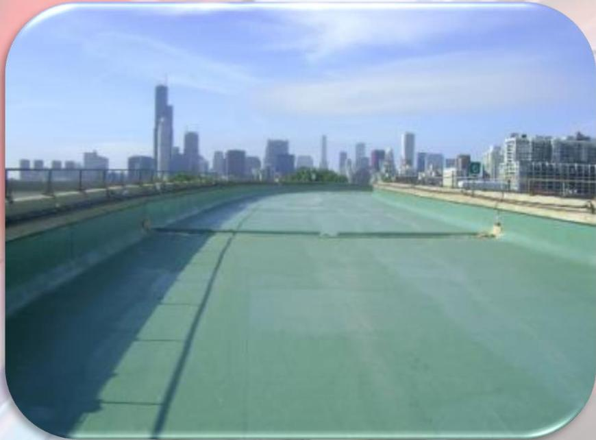
Es un revestimiento elastomérico que proporciona una protección a prueba de agua para ser utilizado como impermeabilizante de las cubiertas de los puentes tanto de hormigón como de acero.
