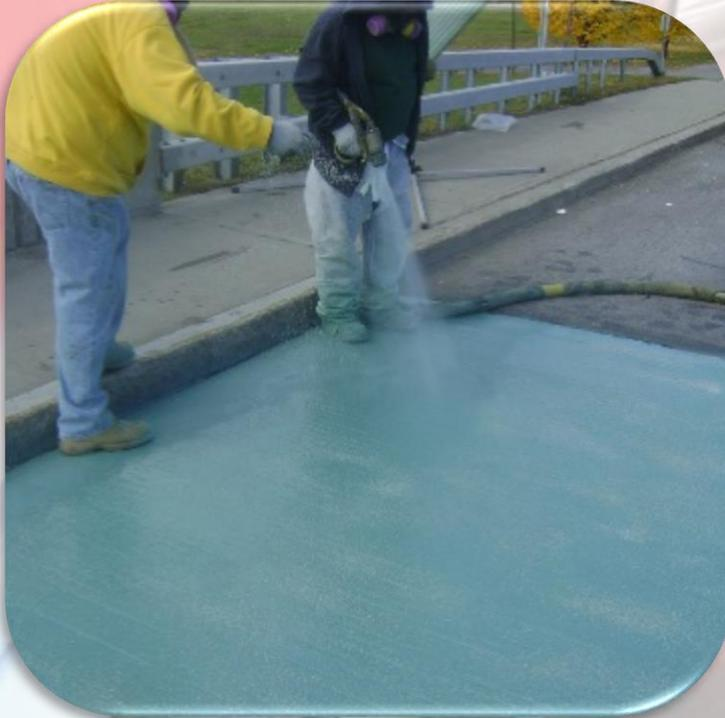
La membrana Deckguard se aplica en Spray, proporcionando una barrera sin costura o uniones, flexible y extremadamente duradera contra la penetración y el flujo superficial del agua.
