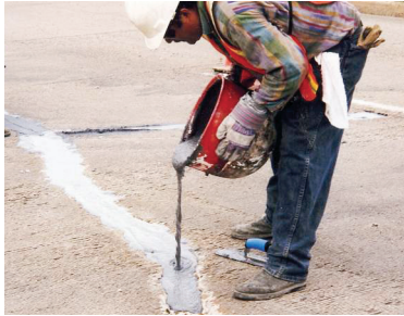
Reparación de losas astilladas y grietas, Carretera 6, Houston, Texas
