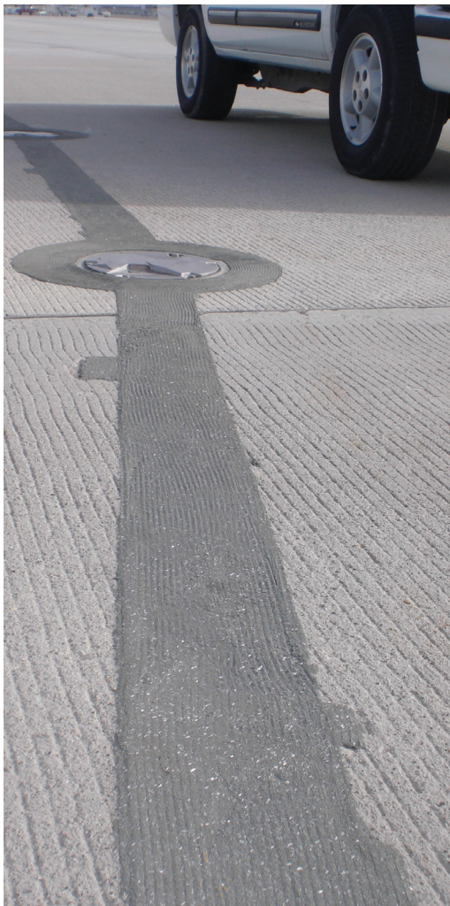
Aplicación de Delpatch™ en obra de iluminación de pista, Aeropuerto Internacional de Salt Lake City, Utah
