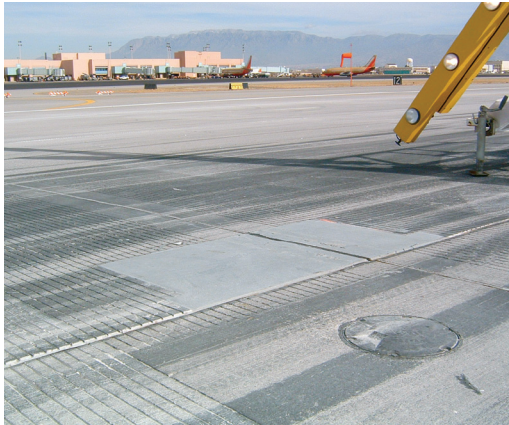
Reparación de losas astilladas con Delpatch™ en la pista del Albuquerque International Sunport, Nuevo México,
